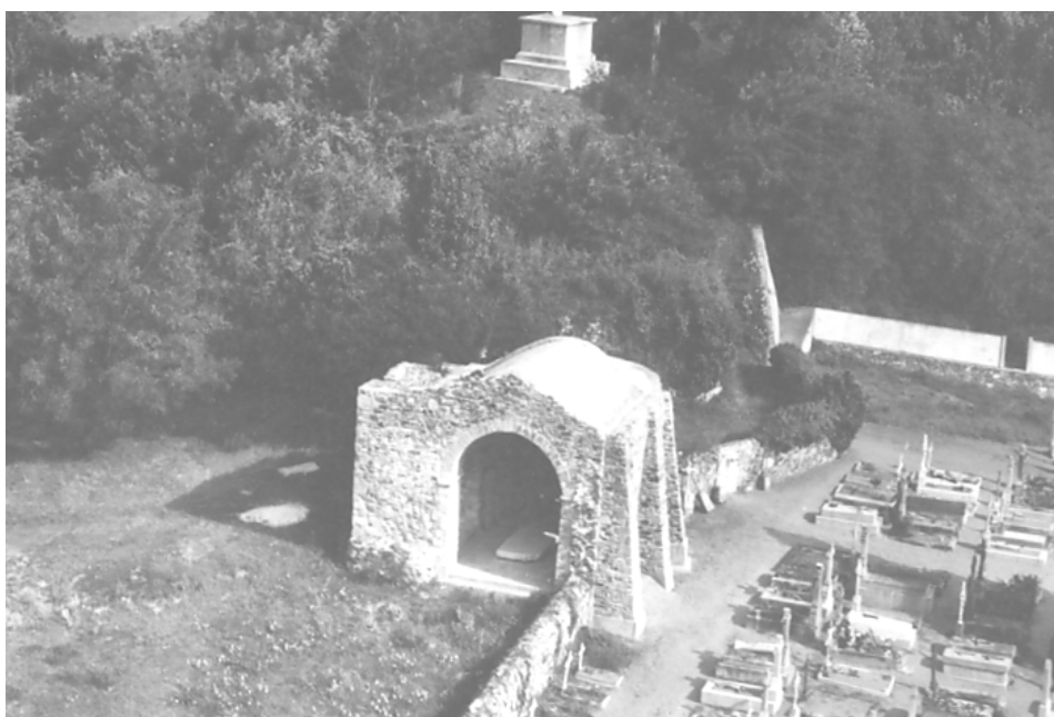
Photo aérienne du site pendant les travaux de restauration. Les travaux de maçonnerie sont terminés, la toiture et la grille ne sont pas encore réalisées. Derrière la chapelle on remarque la végétation qui a envahi les ruines du donjon.
