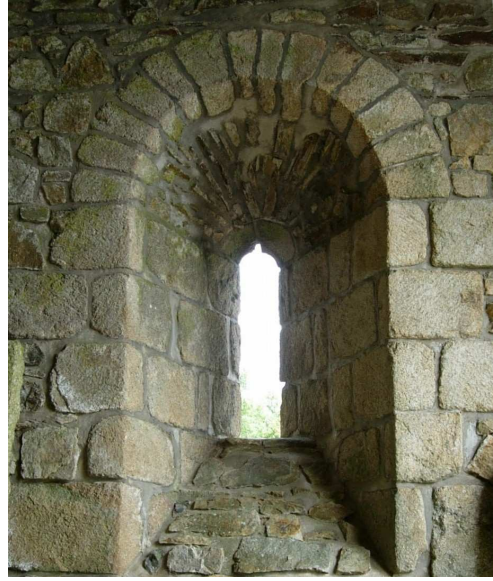
Fenêtre droite de la nef symétrique
