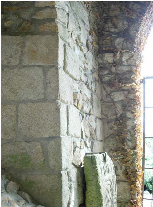
Inclinasion du mur près du porche (15 cm)
