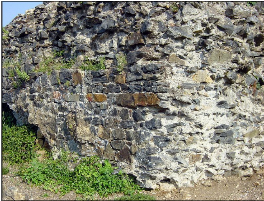
Abbildung 5: Die Südostecke des Donjon, Bruchsteine aus Gabbro.
